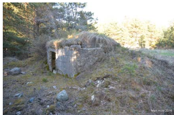
Foto 162. Nõukogude okupatsiooniväest maha jäänud punker Papissaare loodenurgas Püstinukil Kihelkonna metskond 449 maaüksusel. Foto Mart Hiob 2016.
