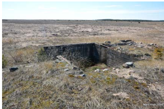
Foto 103. Nõukogude sõjaväe betoonpunkti vare. Foto Mart Hiob 2016.
