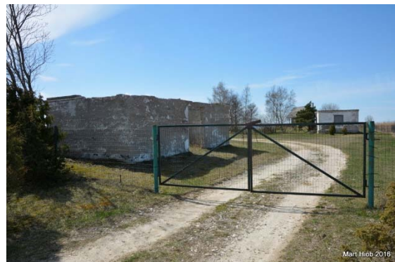
Foto 109. Nõukogudeaegse piirivalvepunkti jäänused – kaks katuseeta hoone müüri – Uue-Kordoni maaüksusel. Foto Mart Hiob 2016.
