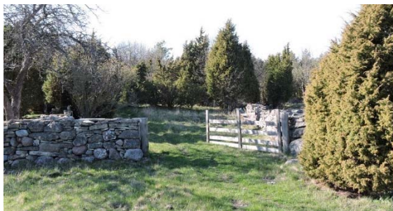
Foto 243. Pärsti-Peetri korrastatud kiviaiad väravaga. Foto Mart Hiob 2016.
