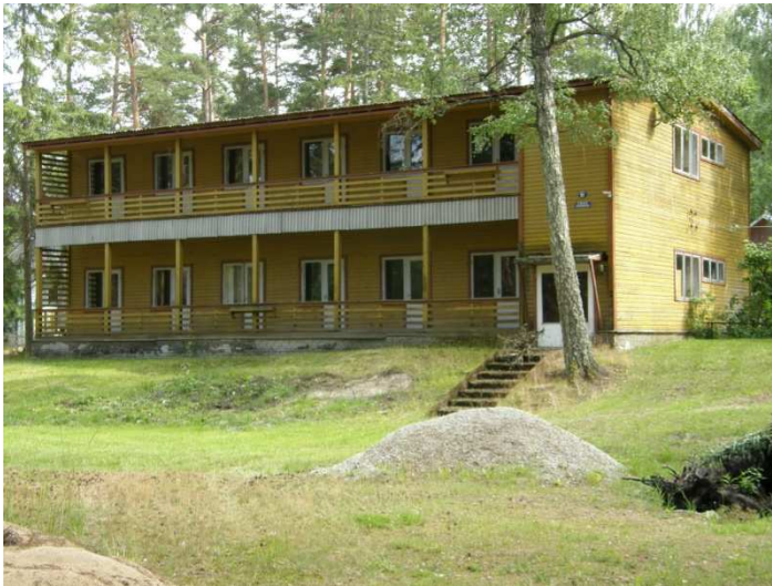
Neist esimesed valmisid veel puhkekodu käsituses olnud natsionaliseeritud suvilate laiendusena – näiteks Mere 91 paiknev majutuskorpus on ehitatud 1967.aastal kunagise Petereburi kindral Sapozhini suvemajast – veranda maht on tagaküljel siiani loetav. Kuigi hoone on ENSV aegse puutarkhitektuuri ja kollektiivse suvitusarkhitektuuri näitena väga huvitav on selle säilitamisperspektiivid ilmselt siiski kasinad. Foto 2008.
